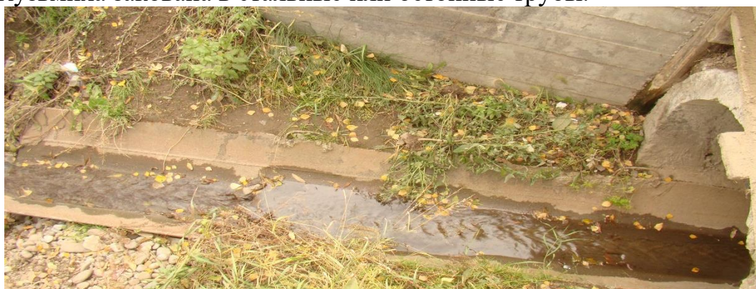
Рис. 4. Река, «закованная» в бетон...
