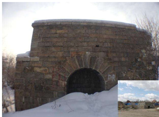
Рис.6. Опоры моста через р. Большая Кузьмиха
