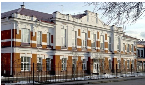
Здание МБОУ г. Иркутска СОШ № 11
